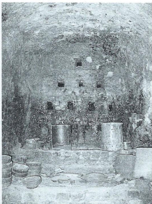
图一四 民国时期宝溪龙窑的多层排烟孔
